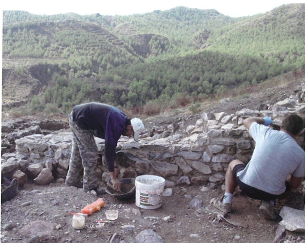
Labores de consolidación de uno de los edificios argáricos
