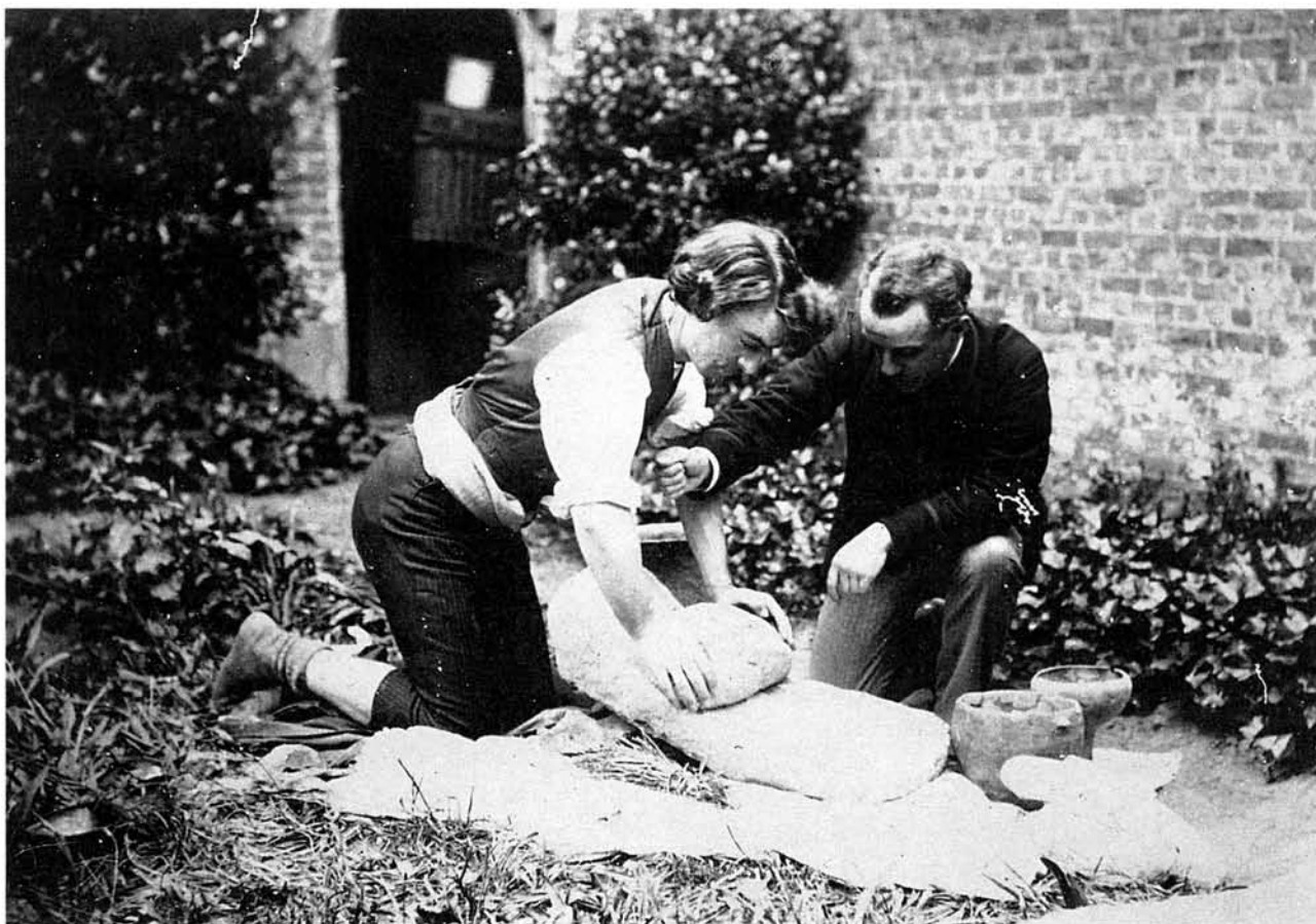
3. Enrique y Luis Siret en la época en que excavaron Gatas. Hacia 1885 (Foto J. Grima).
