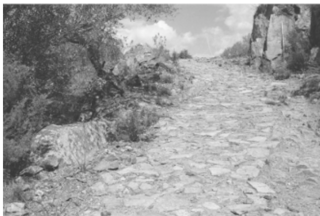
LÁM. I. Tramo Sur. Tramo empedrado.
