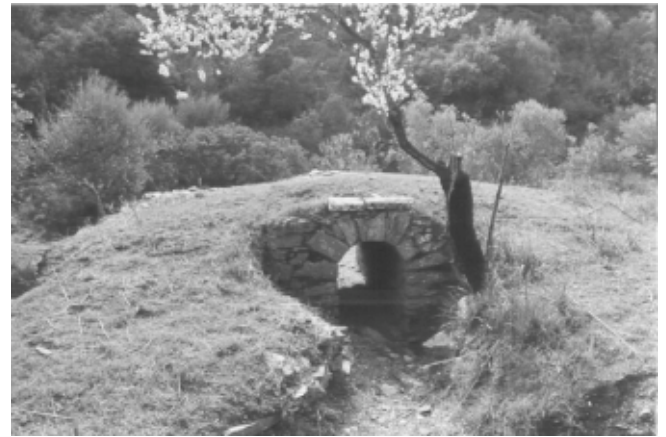
LÁM. II. Tramo E. Alcantarilla 1.
