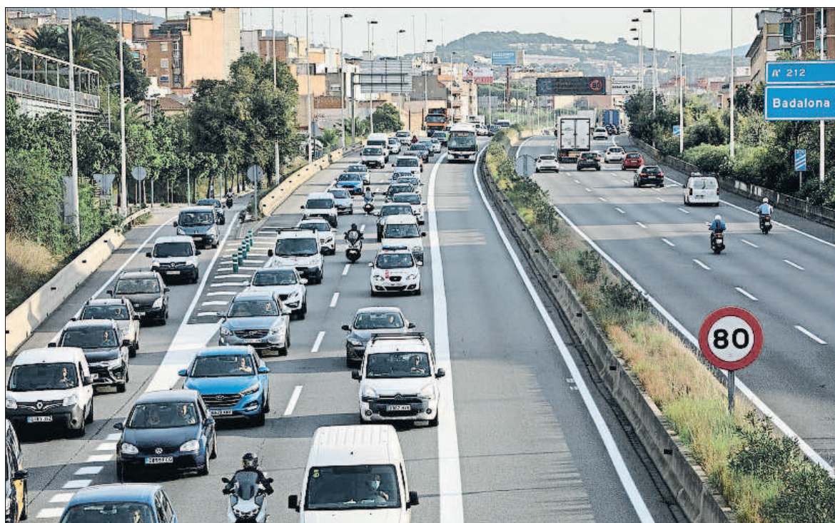
Retencions. Els dos carrils de lliure circulació de la C-31 en direcció sud amb congestió i el carril bus-VAO buit
